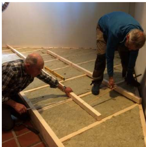
Nygård og Tunheim i full gang med bygging av scene
